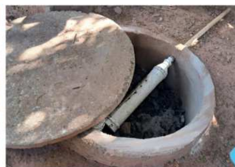
Terceira filtragem da água
