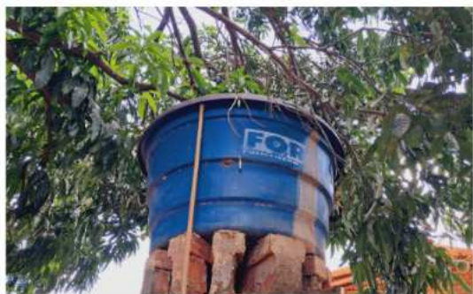
A caixa que filtra a água das louças, banho e lavado de roupa
