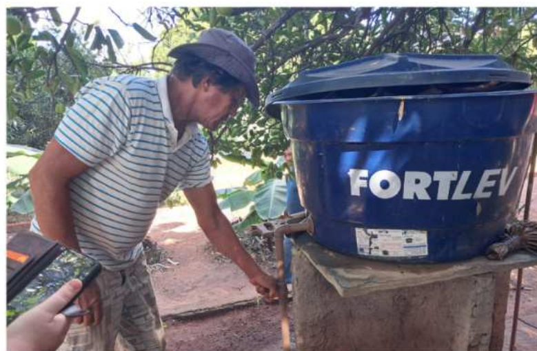
Caixa que armazena a água tratada que é manualmente liberada por seu Chiquinho em direção às plantações do quintal, através do sistema de irrigação
