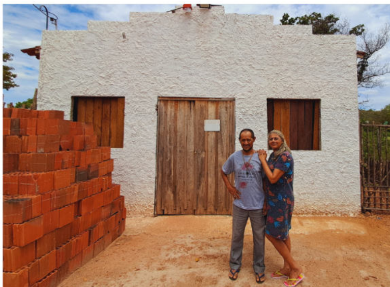
O casal e a igreja ministério Resgatando Vidas, em construção
