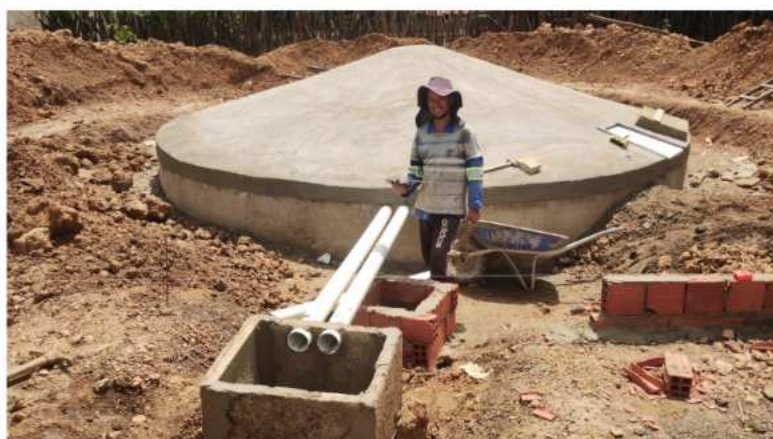
Hélio trabalhando na construção de uma cisterna do P1+2
