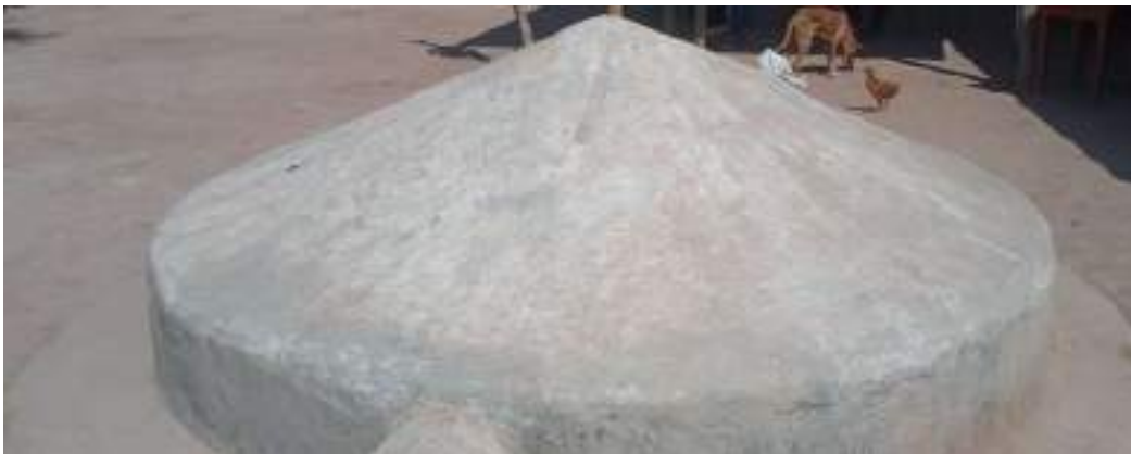
Figura 7: Cisterna para o abastecimento de água para o consumo familiar na comunidade de Cabeza del Toro, Copo/Santiago del Estero/Argentina
