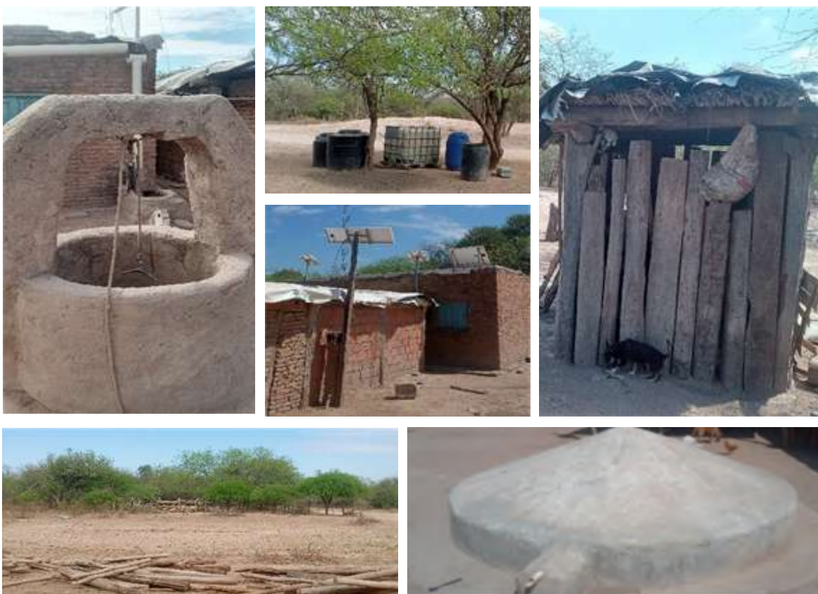
Figura 38, 39, 40, 41, 42 y 43: Mediadores de fertilidad familiares de captura, almacenamiento y/o procesamiento - aljibe (izquierda arriba), represa (izquierda abajo), depósitos de agua (centro arriba), paneles solares (centro abajo), Silo (derecha arriba), cisterna (derecha abajo).
