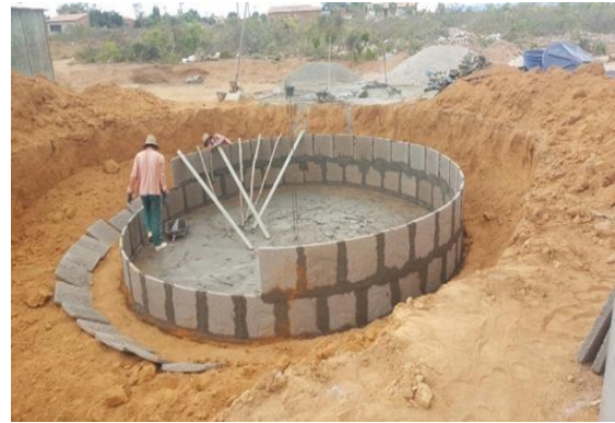
Figura 53 – Construção da cisterna
