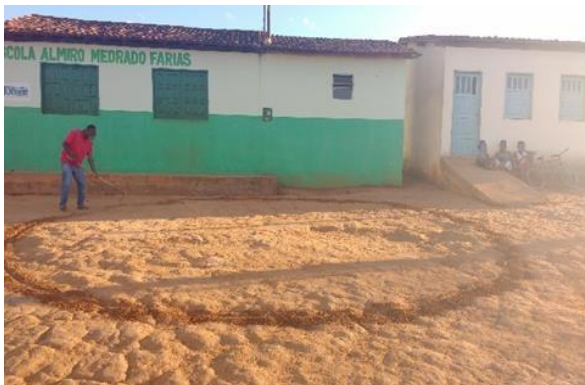
Figura 50 – Demarcação do fosso da cisterna
