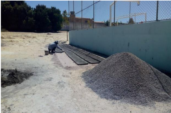
Figura 52 – Construção das placas da cisterna
