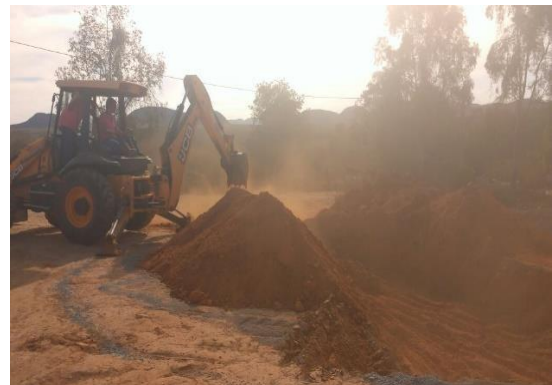
Figura 51 – Escavação do fosso da cisterna
