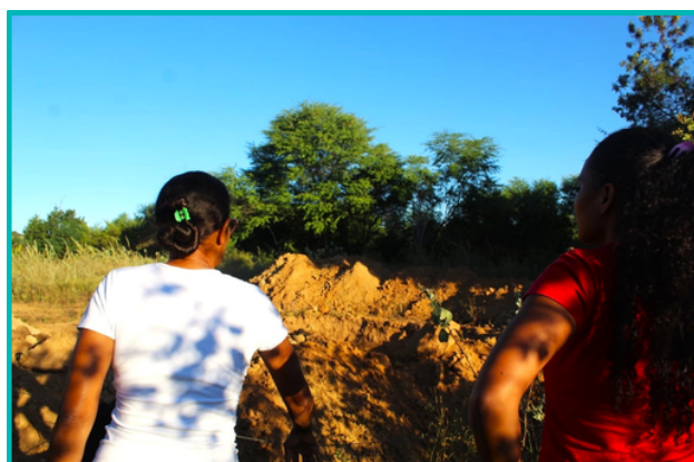
Escavação do buraco da cisterna de produção.
