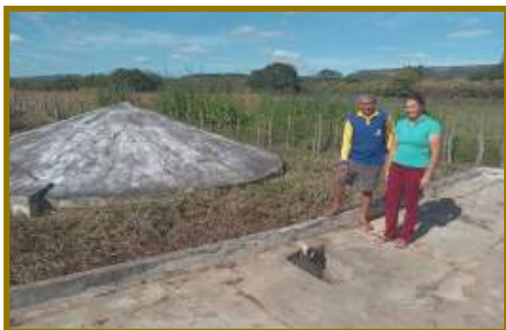
Cisterna calçadão construída em 2014
