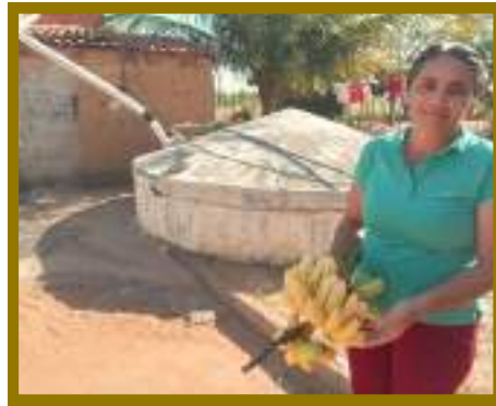
Cisterna de 16 mil litros
