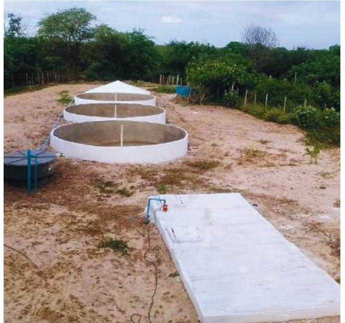
O sistema de tratamento e reúso comunitário é composto por caixa de areia, tanque de equalização, reator UASB, dois tanques com capacidade de 10 mil litros e uma cisterna reservatório de 52 mil litros (que armazena a água para o reúso). Além disso, a tecnologia conta com um sistema para geração de energia solar, que alimenta as bombas.
