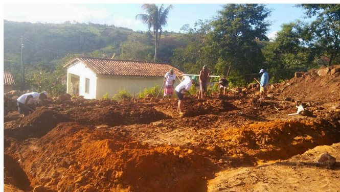
Construção da sede da AMAQUI
