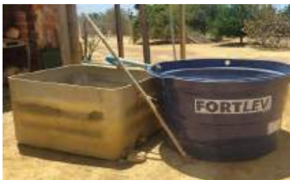
Figura 9: Caixas de armazenamento de água
