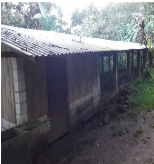
Figura 9 : Instalaciones para producir abonos y fertilizantes orgánicos
