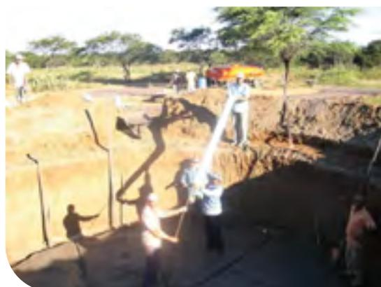
Figure 18 – Barres de fer à la base du pilier central et remplissage du tube avec du béton.
