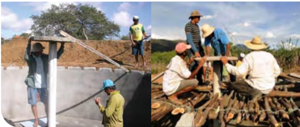
Figure 25 - Fixation de la couronne sur le pilier central.
