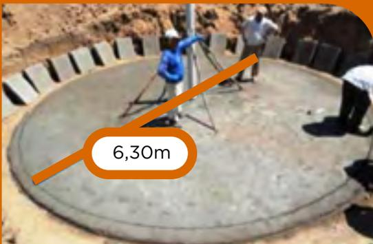
Figure 17 -Fabrication de la 2e dalle.
