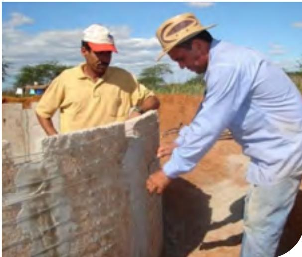
Figure 20 - Image des fils d'acier recuit galvanisés en train d'être tendus et des plaques de la citerne bien tendues et bien distribuées.
