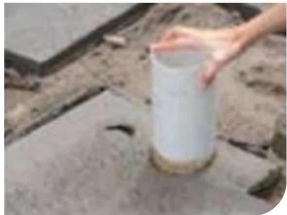
Figure 9 - Plaques perforées utilisant le tube de 100 mm comme moule.
