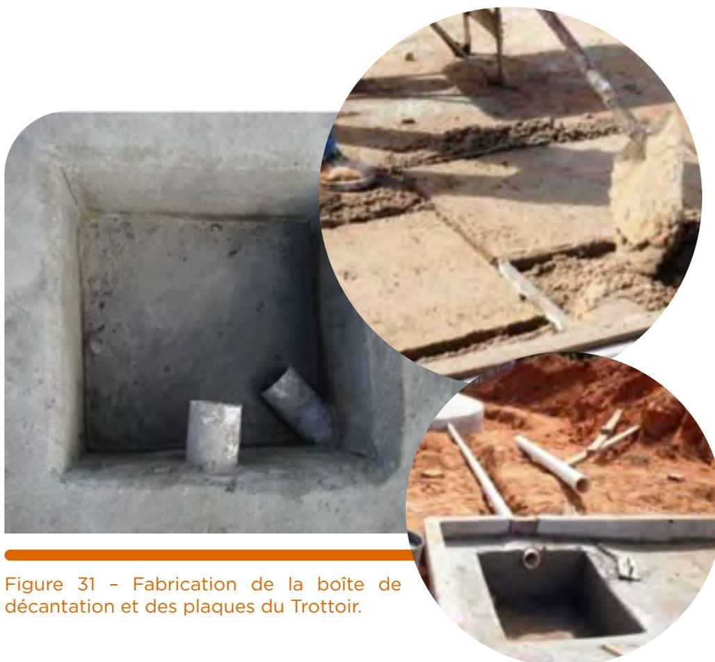
Figure 31 - Fabrication de la boîte de décantation et des plaques du Trottoir.
