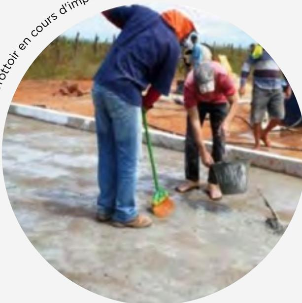
»» Une fois l'imperméabilisation terminée, la peinture du Trottoir doit être faite. La peinture est réalisée avec chaux hydratée, avec suffisamment de couches pour rendre la couleur uniforme.
