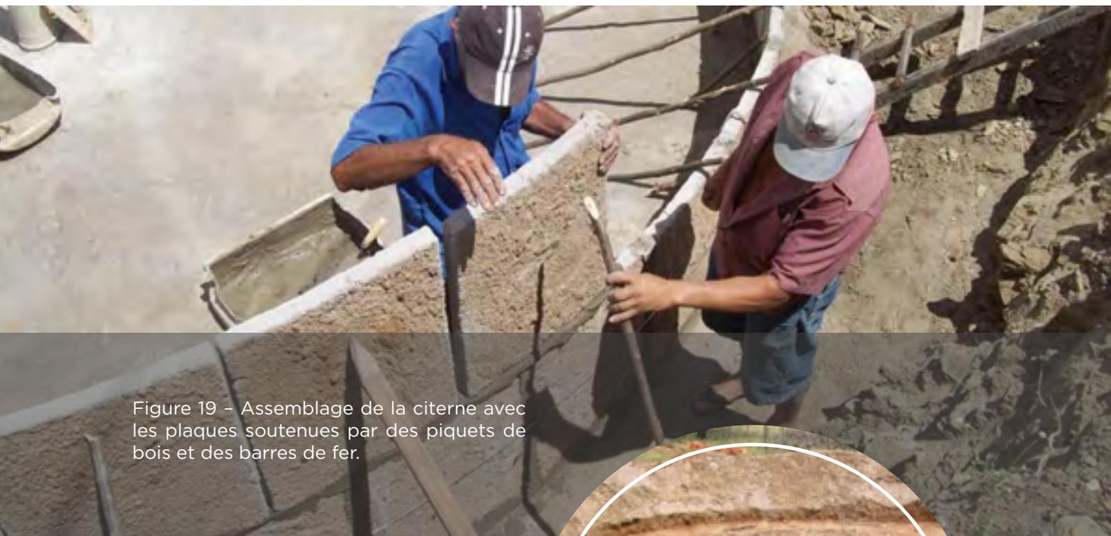
Figure 19 - Assemblage de la citerne avec les plaques soutenues par des piquets de bois et des barres de fer.
