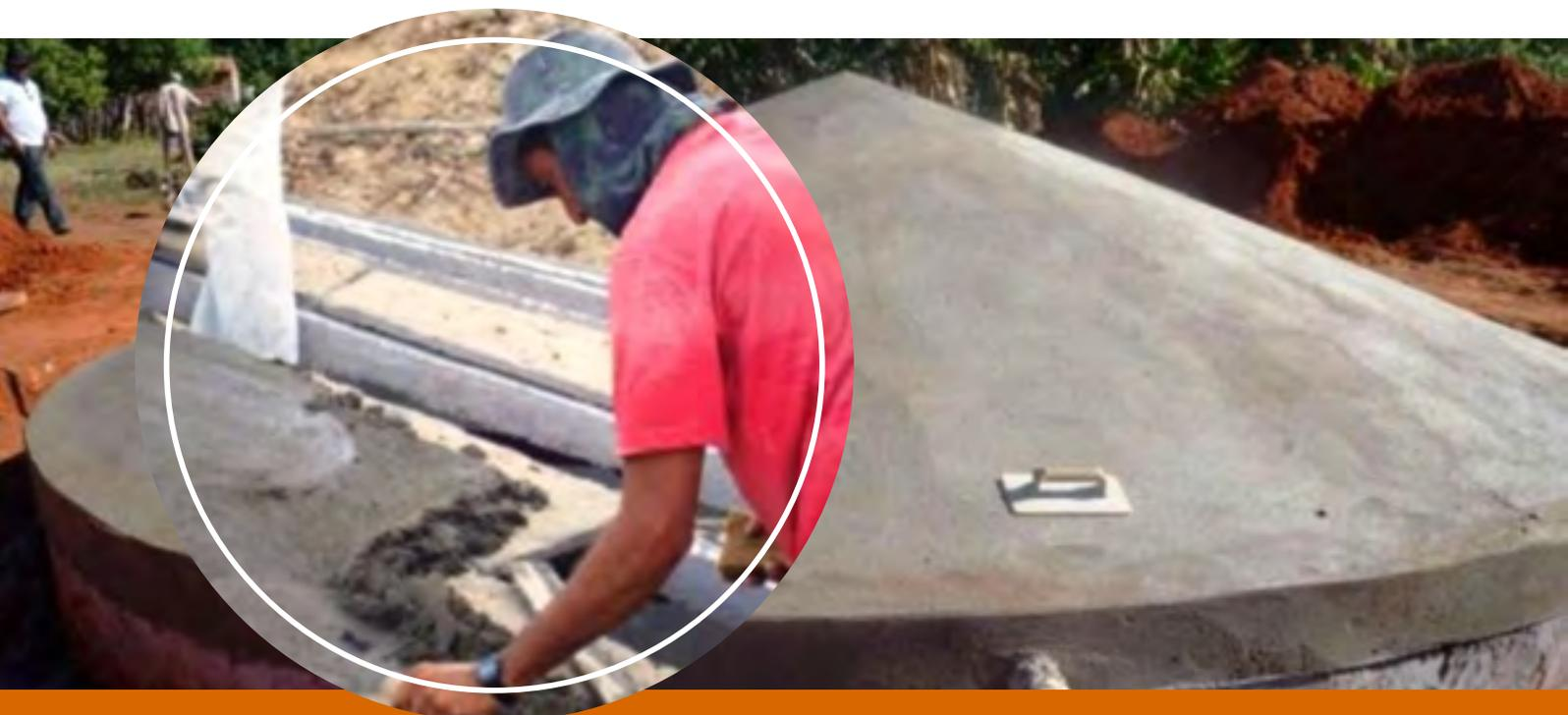
Figure 28 -Enduit de couverture en cours de fabrication et l'enduit fini avec la bande (bord).
