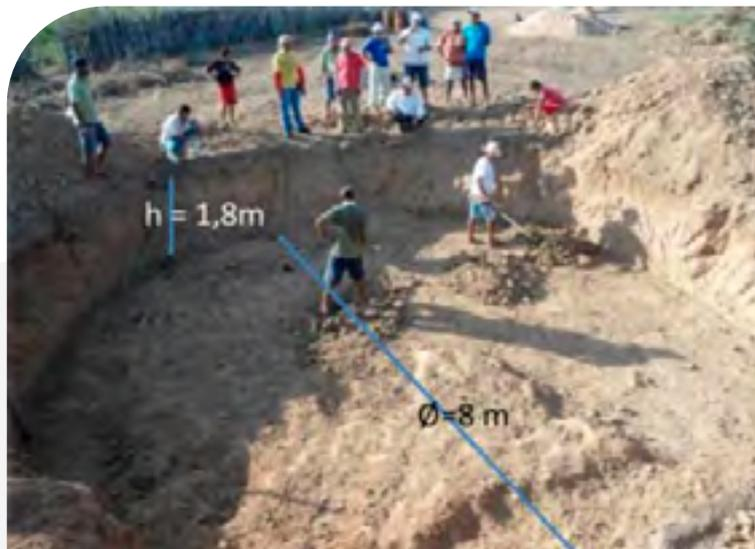
Figure 5 - Nivellement du trou de la citerne.
