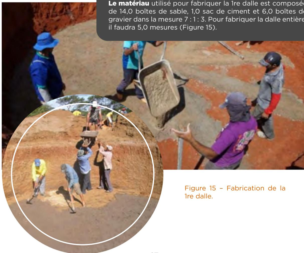
Figure 15 - Fabrication de la 1re dalle.
