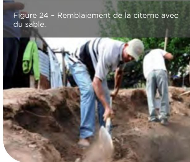
Figure 24 - Remblaiement de la citerne avec du sable.
