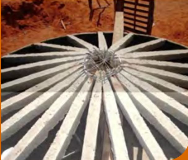
Figure 27 – Image des poutres attachés et en train d'être bétonnée.
