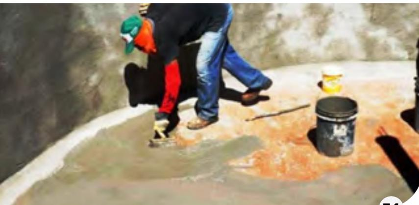
Figura 22 - Imagem da cisterna impermeabilizada com pinceladas de impermeabilizante (golda).
