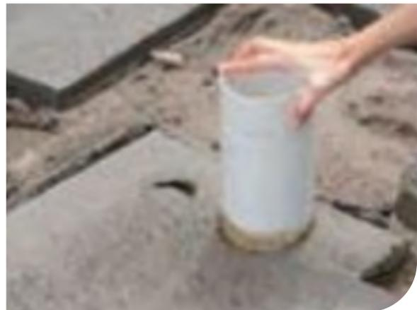
Figura 9 - Imagem das placas furadas utilizando como molde o cano de 100 mm.
