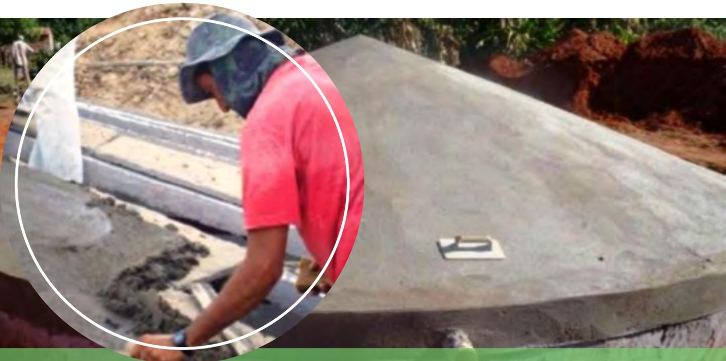
Figura 28 – Imagem demonstrando o reboco da cobertura sendo confeccionado e reboco concluído com a faixa (borda).
