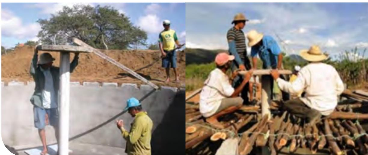
Figura 25 - Imagem demonstrando a fixação da coroa sobre o pilar central.
