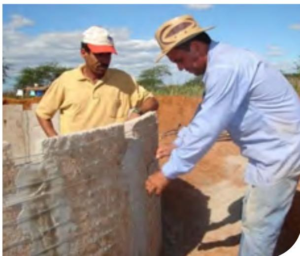
Figura 20 - Imagem dos arames galvanizados sendo apertados e das placas da cisterna amarrada, apertada e bem distribuída.
