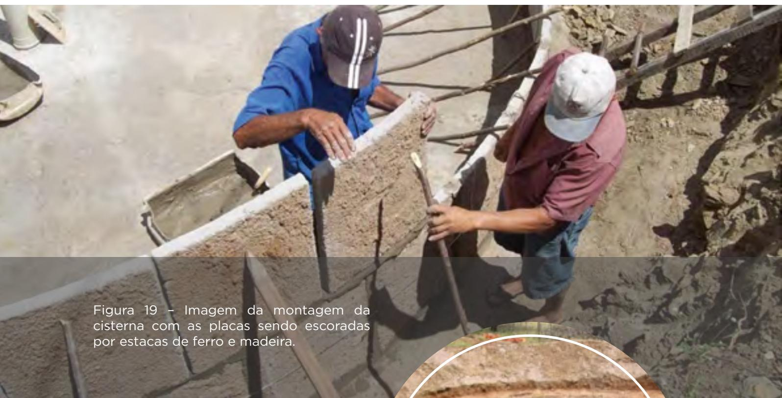
Figura 19 – Imagem da montagem da cisterna com as placas sendo escoradas por estacas de ferro e madeira.
