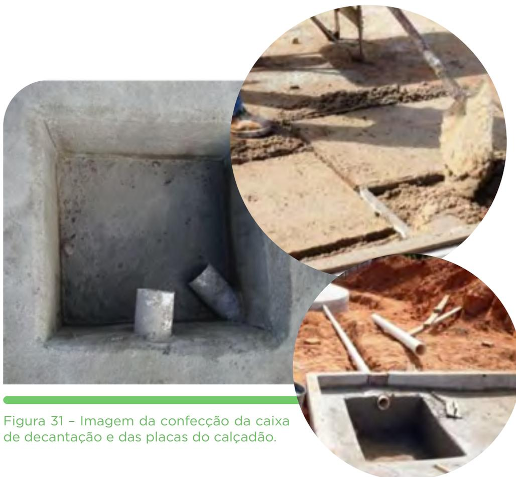
Figura 31 - Imagem da confecção da caixa de decantação e das placas do calçadão.
