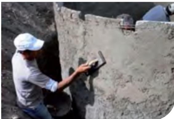
Figura 23 - Imagem do reboco externo sendo confeccionado.
