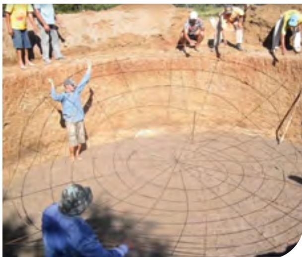
Figura 16 - Imagem da confecção da grade sendo colocada sobre a 1ª laje.
