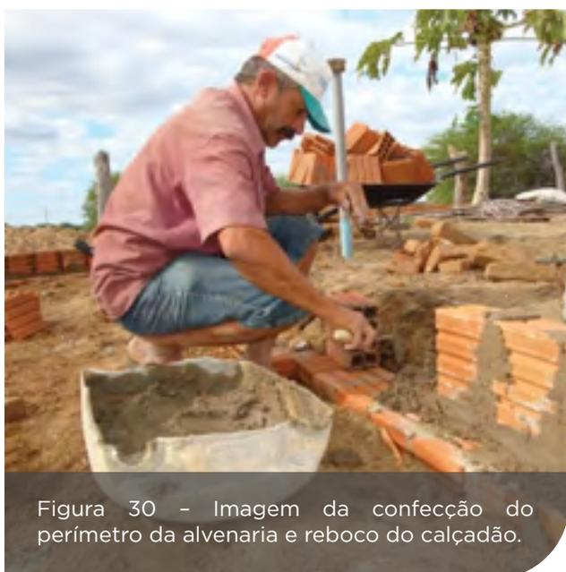
Figura 30 - Imagem da confecção do perímetro da alvenaria e reboco do calçadão.
