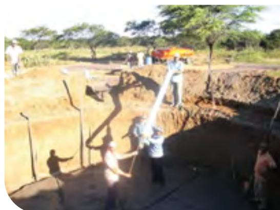
Figura 18 - Imagem dos ferros da base do pilar central e do mesmo sendo preenchido com concreto.
