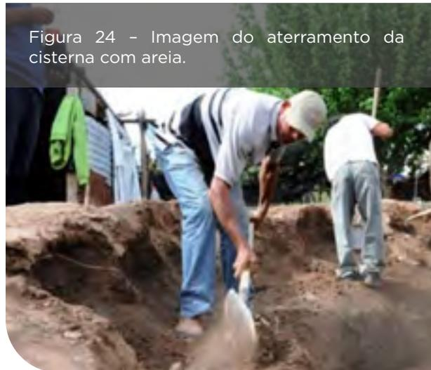
Figura 24 - Imagem do aterramento da cisterna com areia.
