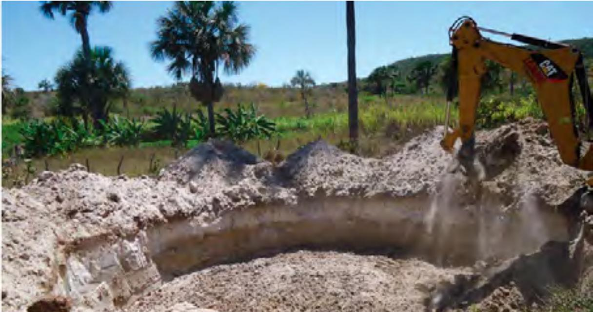
Figura 4 - Imagem da escavação utilizando máquinas (retroescavadeira).
