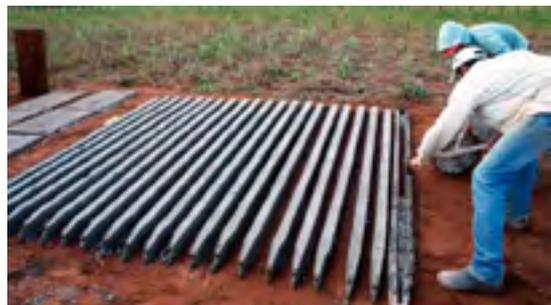
Figura 12 - Imagem dos ferros dos caibros dobrados e dos caibros sendo confeccionados.
