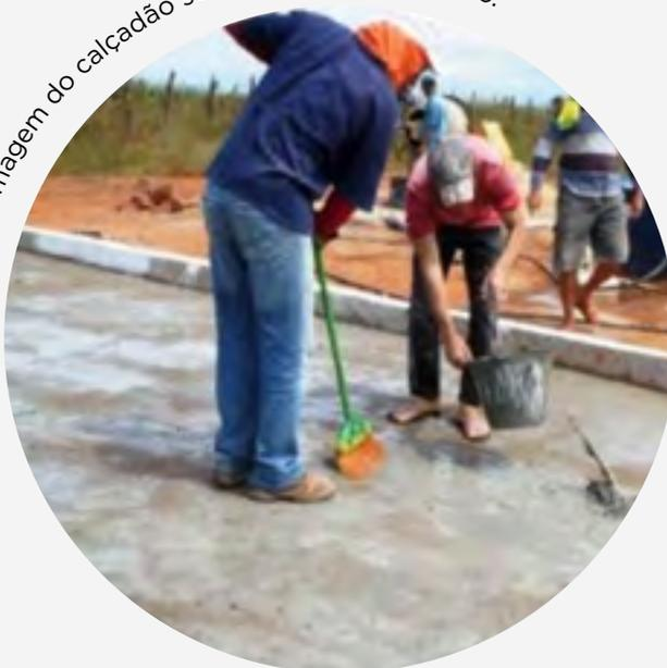
⇒ Terminado o serviço de impermeabilização, deve-se fazer a **pintura do calçadão**. A pintura é feita com cal de cor branca com as demãos suficientes para a cor ficar uniforme.
