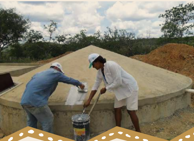
Foto 20 – Pedreiro pintando a cisterna
