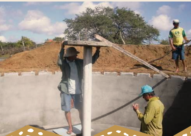
Foto 16 – Colocação da coroa central
