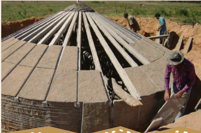
Foto 18 – Construção do teto da cisterna
