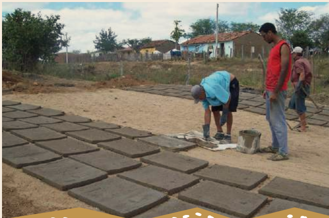
Foto 3 – Confeção das placas da parede
