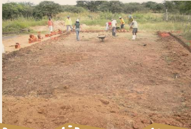
Foto 21 – Mutirão para preparar o calçadão
