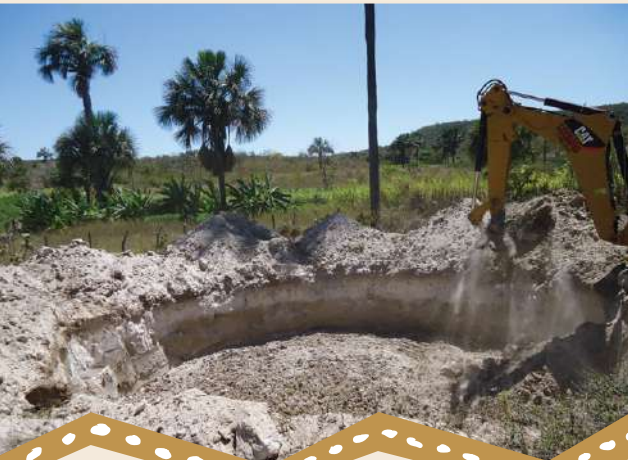
Foto 2 - Escavação com máquina
