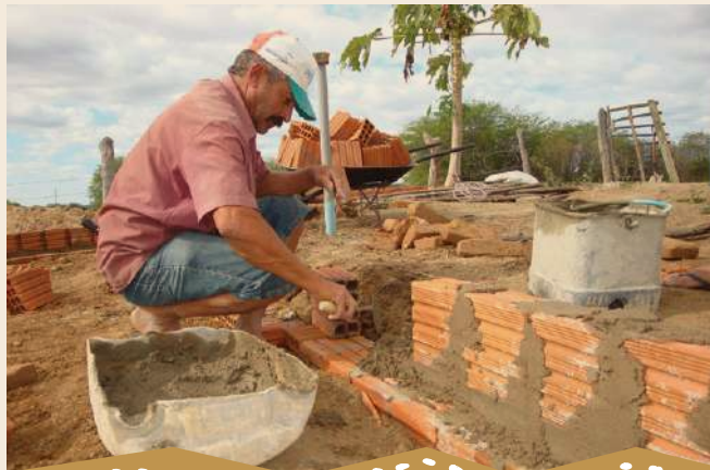
Foto 22 – Pedreiro construindo o muro do calçadão
