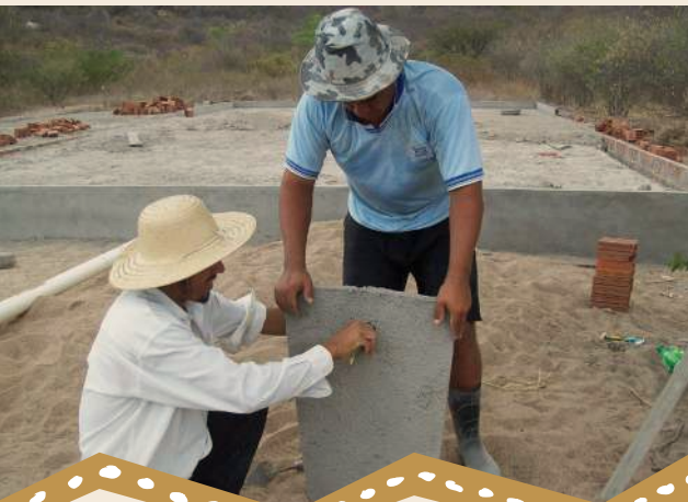
Foto 9 – Detalhe do pedreiro furando a placa
