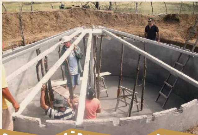
Foto 17 – Colocação das vigas
