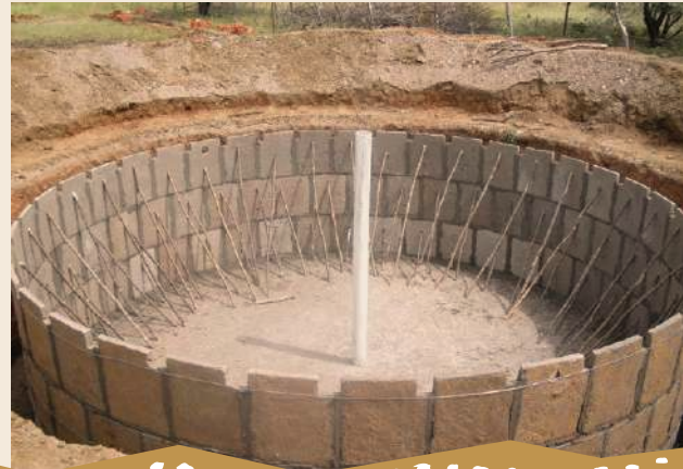
Foto 11 – Detalhe da coluna central pronta
