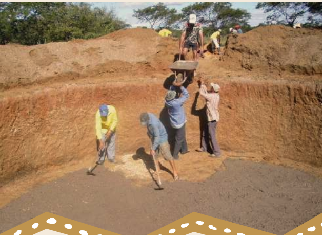
Foto 6 – Confeção do piso do fundo da cisterna
