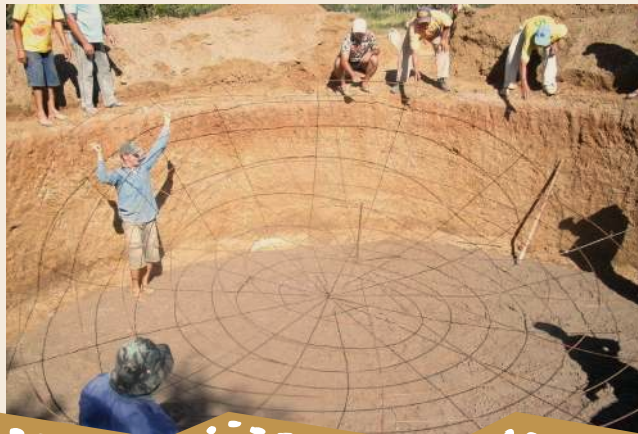
Foto 7 – Fixação da grade no piso
