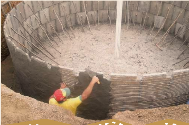
Foto 14 – Reboco externo da cisterna
