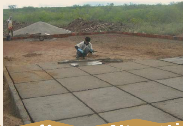
Foto 23 – Construção do calçadão com placas de cimento
