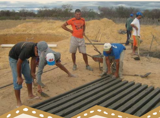
Foto 4 - Confeccões das vigas do teto da cisterna.
