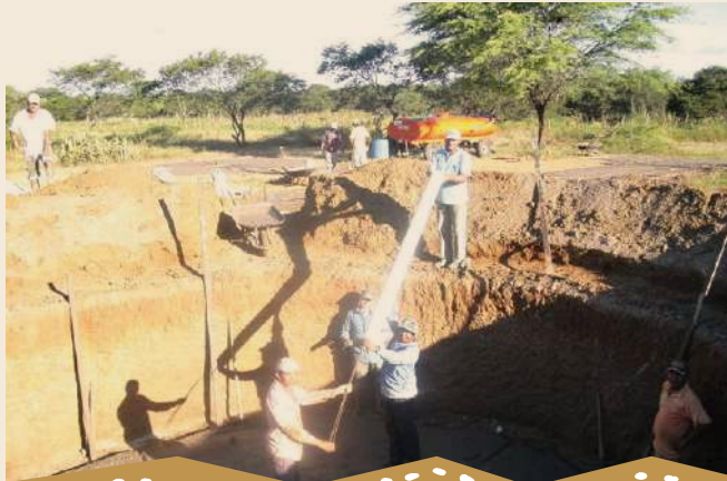
Foto 10 – Colocação da coluna central, feita de cano
