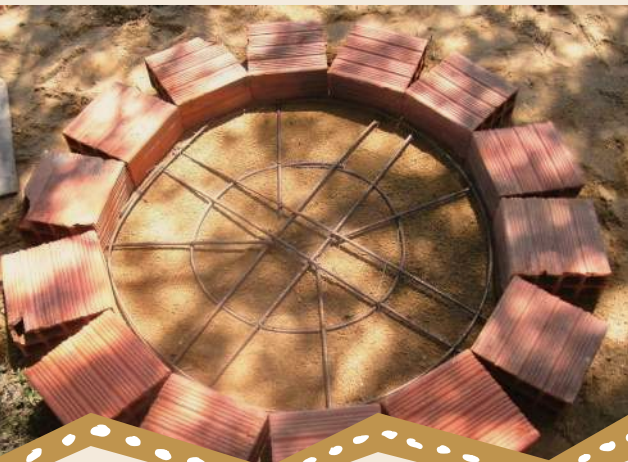
Foto 12 – Armação de ferro do pião central
