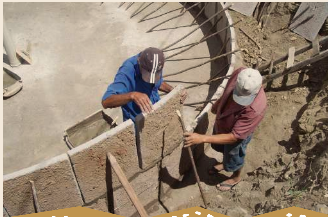
Foto 8 – Construção da parede da cisterna
