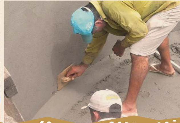
Foto 15 – Reboco interno do fundo da cisterna
