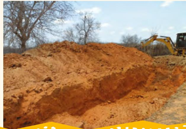
A máquina deve entrar na valeta e escavar até a profundidade determinada na sondagem. O material retirado deve ser depositado nos dois lados do barreiro-trincheira, não muito próximo de suas laterais. Essa medida permitirá diminuir a velocidade do vento por cima da superfície da água, evitando perdas por evaporação.
