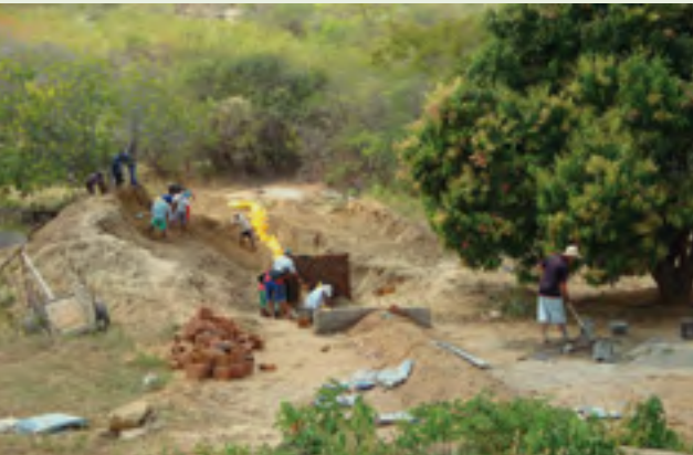
Foto 2 – Área onde a barragem será construída precisa ser próxima à casa da família
