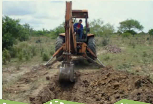
Foto 7 – Escavação com máquina
