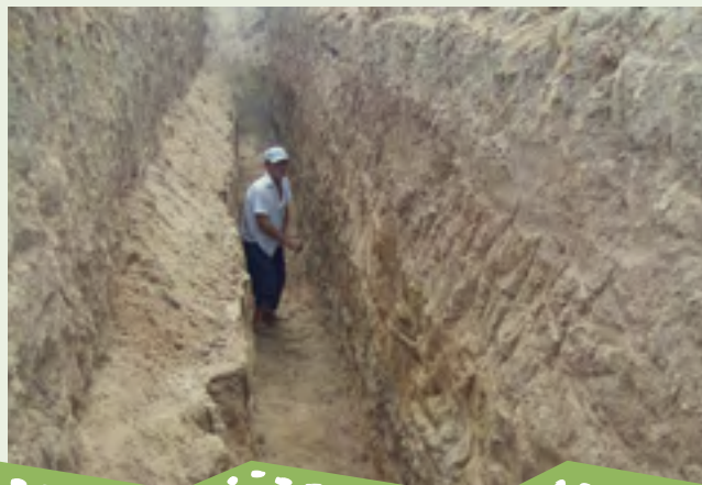
Foto 5 – Pedreiro medindo o tamanho do barramento
