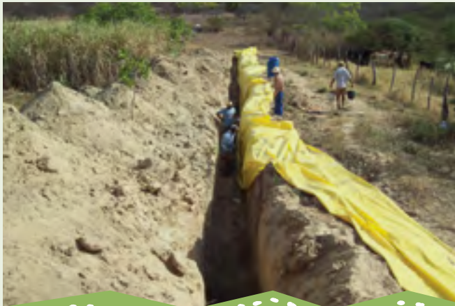
Foto 8 – Colocação da lona plástica
