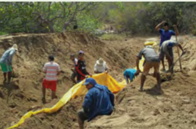
Foto 10 – Aterramento da lona – Riacho Fundo – Afogados da Ingazeira (PE)
