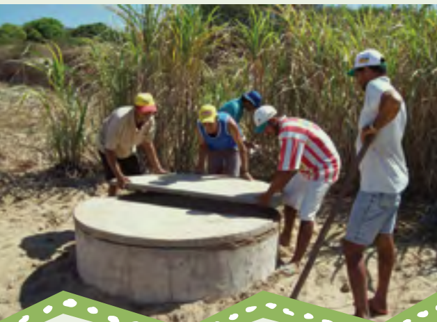
Foto 12 – Pedreiros finalizando a construção do poço
