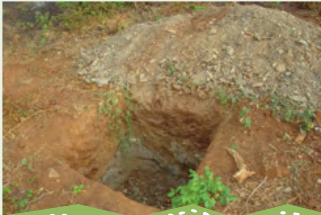
Foto 3 – Sondagem para localização das ombreiras
