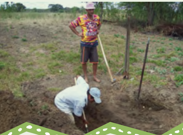
Foto 4 – Sondagem no local onde será construída a barragem
