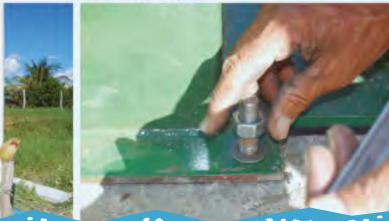
Repetir este procedimento enquanto for preciso, até que a bomba fique firme e nivelada.
