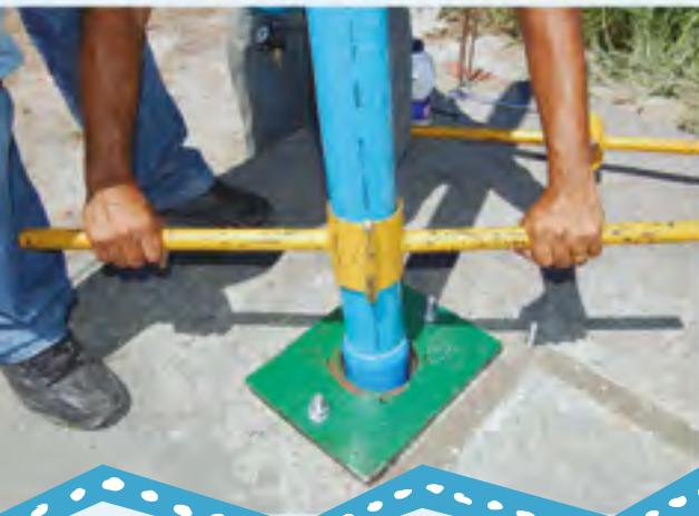
No último cano, antes de retirar a prensa, colocar o 'equipamento de pesca' (pescador de tubo, que faz parte do kit ferramentas) com a corda fixada para sacá-lo (foto 11). Após assentar a luva na chapa, pressionar o pescador para baixo e puxar a corda ao mesmo tempo até retirar o equipamento da luva.
