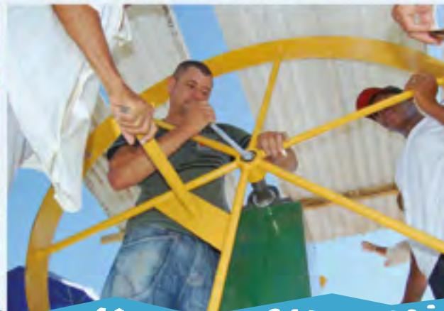
Montar a arruela de encosto, o parafuso e apertar com uma chave de boca de 30 milímetros. Depois de montado, usando uma engraxadeira, lubrificar as graxeiros dos mancais até a graxa sair pelas juntas esféricas.
