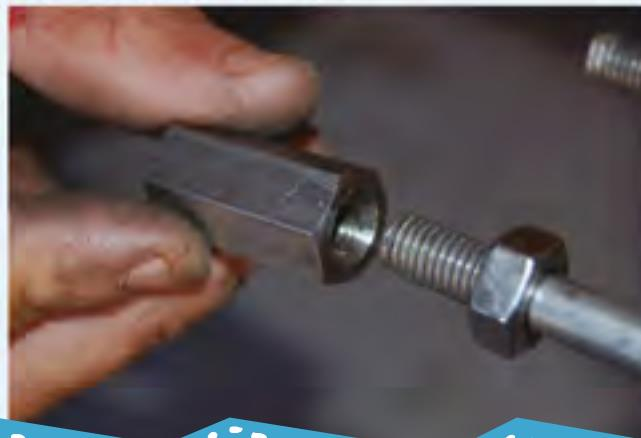
Agora é hora de começar a montar os pares de espaçadores na vareta, utilizando 2 chaves de boca de 18 milímetros. Os espaçadores vão ficar localizados a 20 centímetros da porca em cada uma das extremidades e vão trabalhar junto às paredes internas da tubulação, evitando que as varetas fiquem empenadas com o tempo (foto 4).
