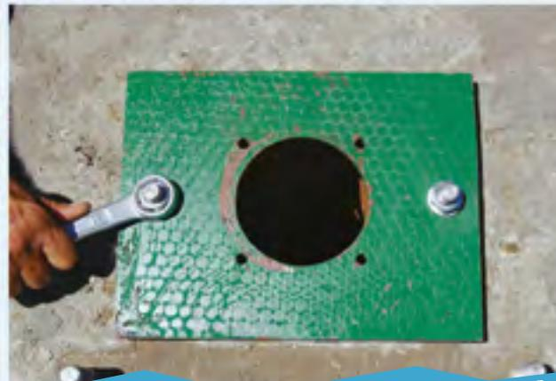
A tubulação montada é colocada no interior do furo e é prensada na face da chapa. Com o auxílio de outra prensa de grampo, montar a união (emenda) e nela outro tubo (foto 10). O tempo de cura da cola é de 10 minutos. Após esse tempo deve-se erguer o tubo, retirar a prensa inferior e baixar cuidadosamente o tubo.
