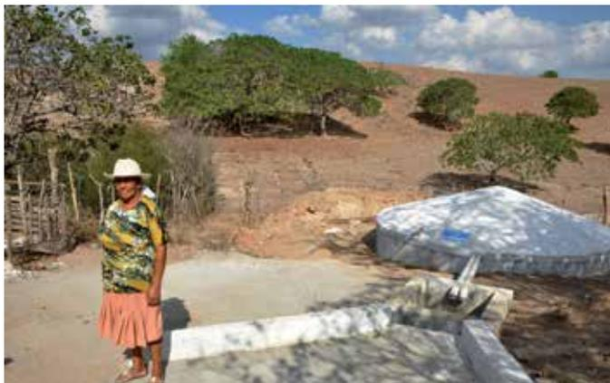
As cisternas calçadão têm esse nome porque a área de captação de água é uma calçada de 200 metros quadrados, feita com uma cisterna em declive próxima à área de produção
