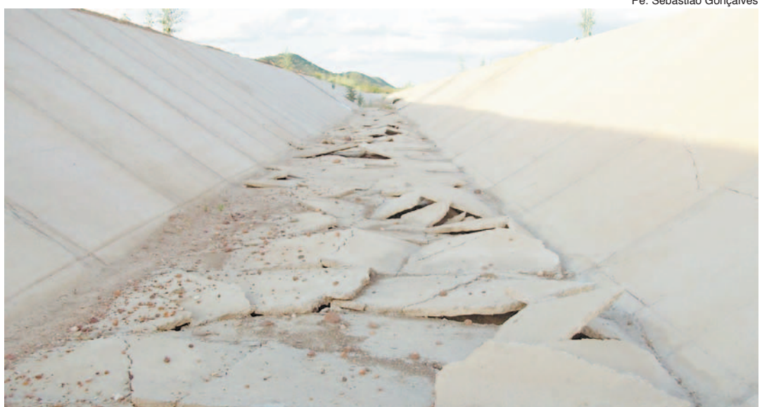
Transposição: rachaduras nos canais e paralisação das obras
