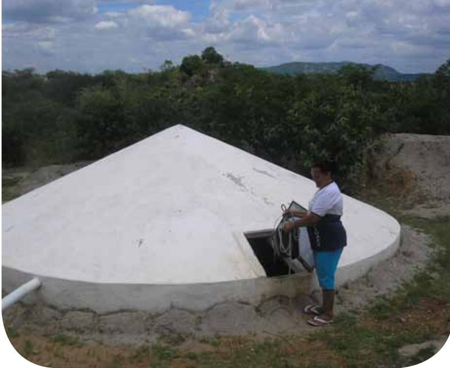
A cisterna Calçada guarda água da chuva para produção de alimentos e é uma tecnologia social desenvolvida pelo Programa Uma Terra e Duas Águas (PI+2)*
